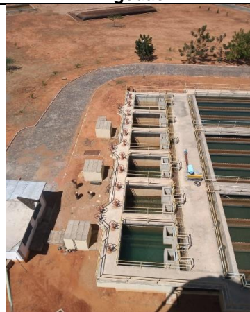
Figura 12 – Vista parcial dos filtros da ETA do Algodão
