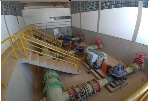
Figura 24 – Conjuntos moto-bombas da Estação Elevatória de Água Tratada 3 do Sistema do Algodão
