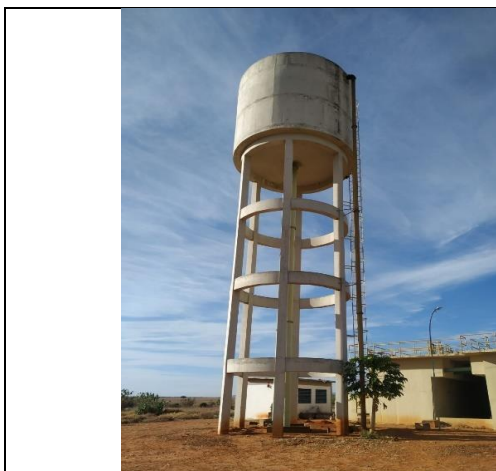
Figura 19 – Estação Elevatória de Água Tratada - EEAT 1 do Sistema do Algodão
