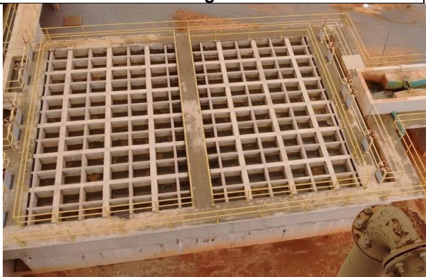
Figura 10 – Calha Parshall e floculadores da ETA do Algodão
