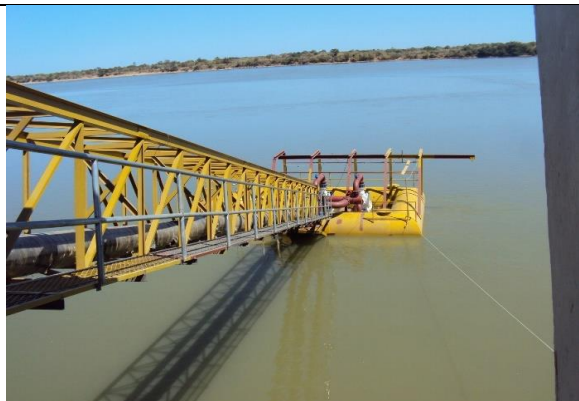
Figura 9 – Estação Elevatória de Água Bruta - Rio São Francisco
