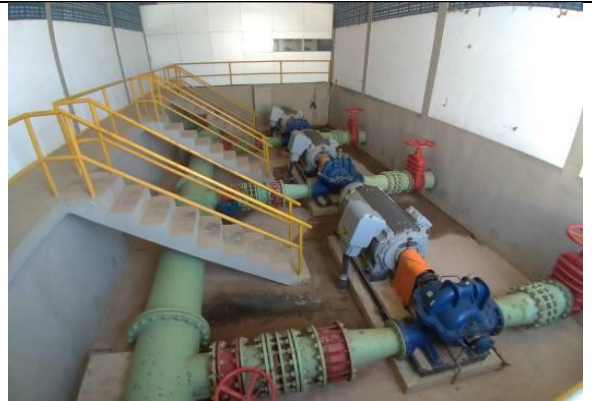
Figura 24 – Conjuntos moto-bombas da Estação Elevatória de Água Tratada 3 do Sistema do Algodão
